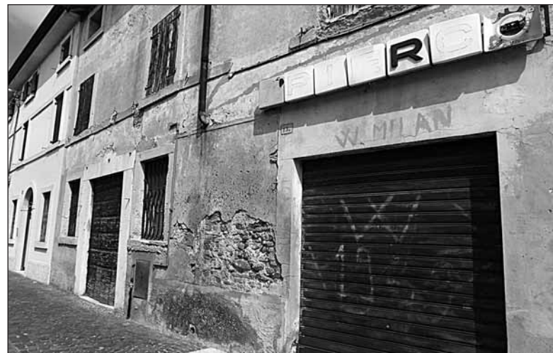
Edifici del centro storico di Povegliano da ristrutturare
