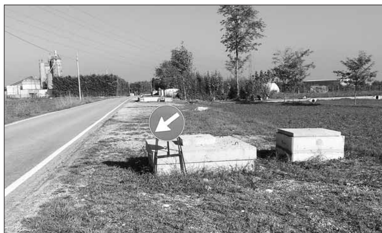
Canale intubato tra Povegliano e Alpo di Villafranca
