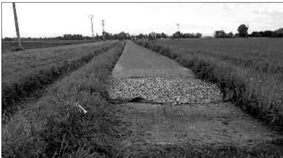
Un tratto della pista ciclabile in costruzione a Povegliano Veronese
