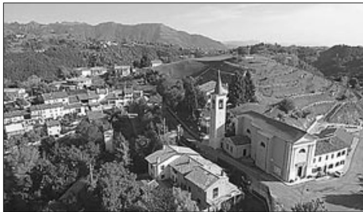
Veduta aerea di Badia Calavena con la frazione Ca' del Diavolo
