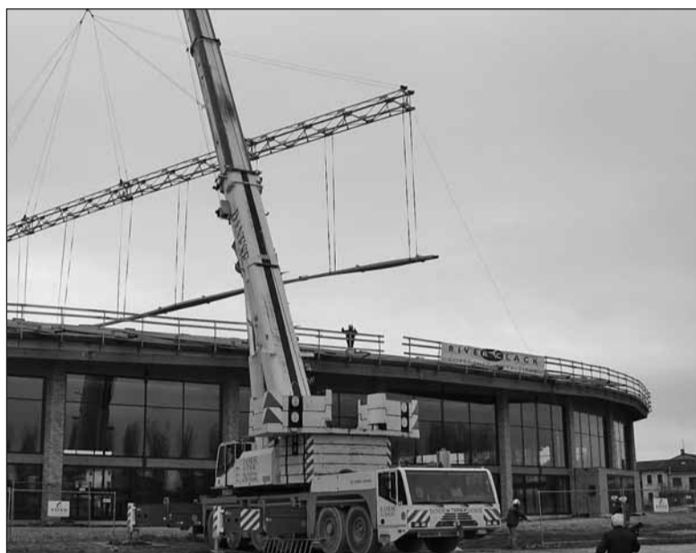
I lavori di copertura della megastruttura sede del Centro Risi
