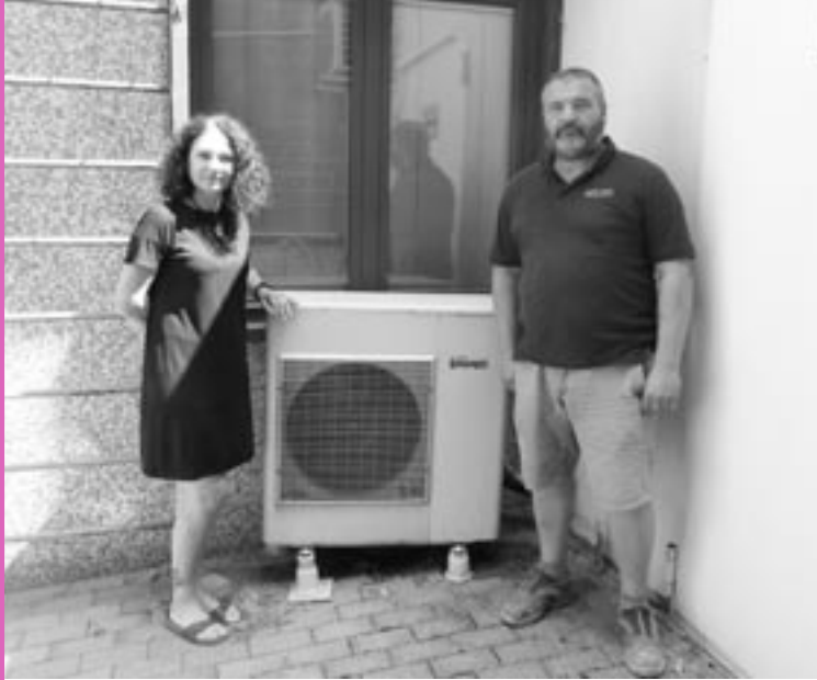
Marco Bergamini e Arianna Gelio con pompa di calore
